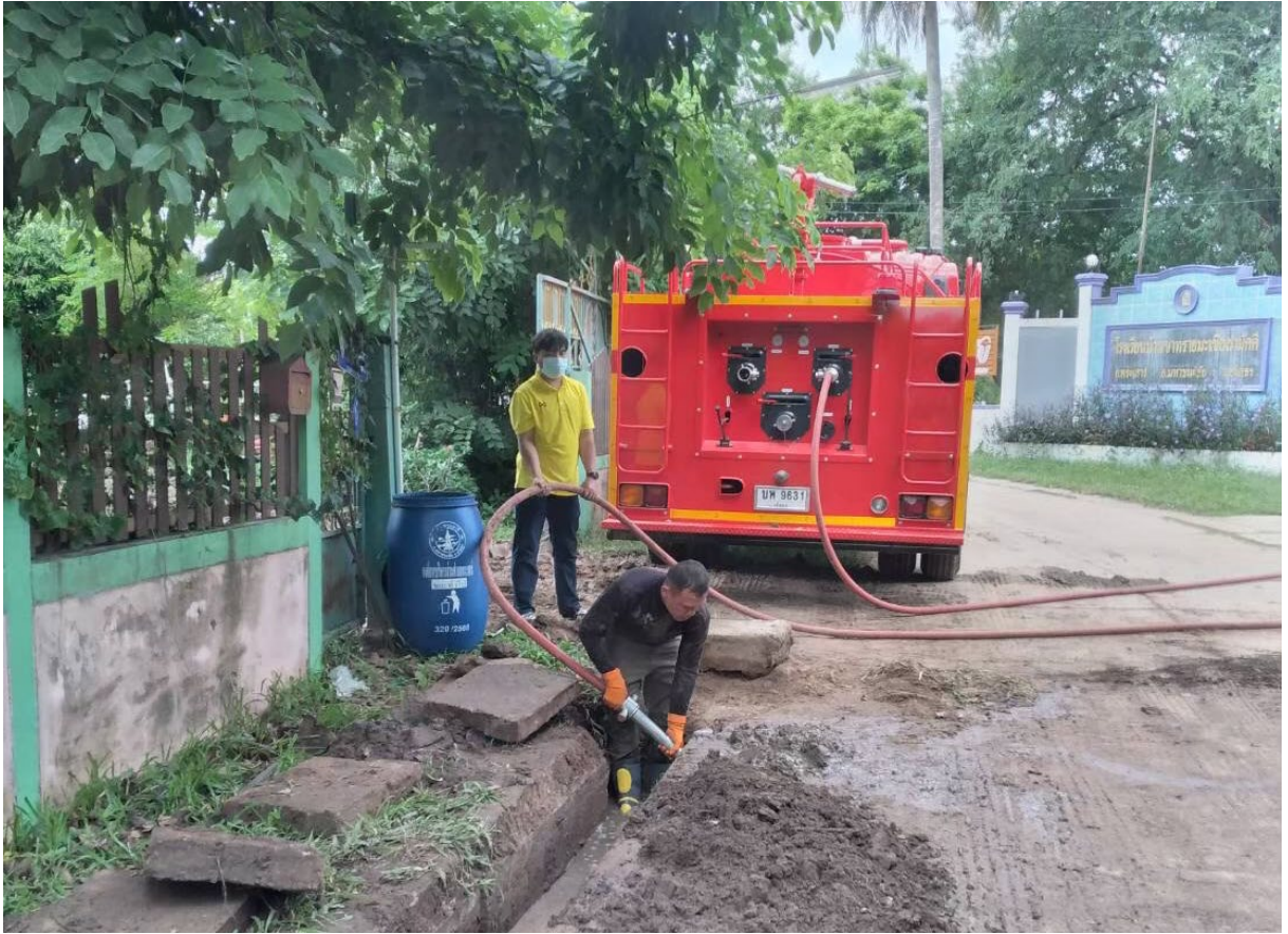
ชุดลอกทรายระบายน้ำภายในหมู่บ้าน บ้านเขาทราย หมู่ที่ ๔
